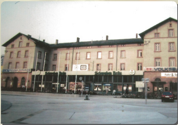
1987: Der Bahnhof vor dem Abriss
